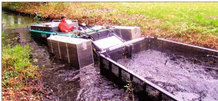
Eines der Spezialfahrzeuge reinigt den Flusslauf, indem Morast abgetragen wird. Durch den Einsatz im Wasser spielt der Korrosionsschutz bei den Fahrzeugen eine wichtige Rolle. Quelle: Conver
