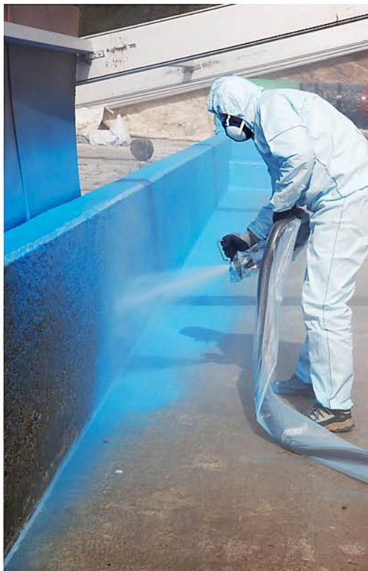
Polyurea-Beschichtungen kommen unter anderem als Auskleidung für Wasserleitungen und -behälter zum Einsatz, in diesem Fall zur Schwimmbadsanierung
