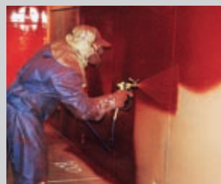
Revêtement de wagons en Pologne
