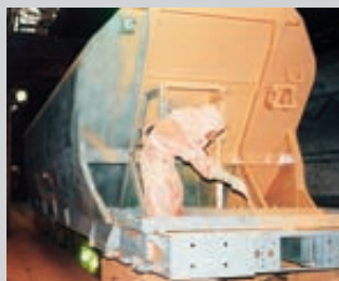
Revêtement de wagons en Pologne
