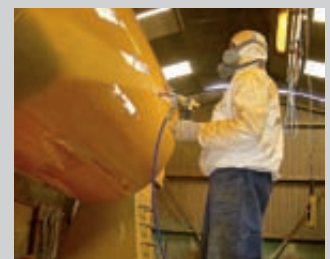
Revêtement de citernes en Belgique
