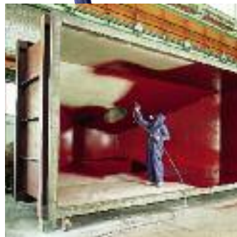
Dans la construction métallique on demande une haute performance et une bonne maniabilité.
