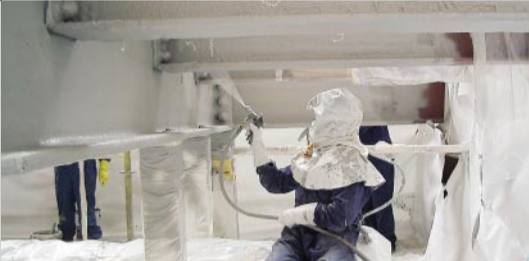
Beschichtung einer Filteranlage zur Gasreinigung mit Chartek-Brandschutzmaterial im Heerema Werk in Zwijndrecht, Holland. Coating of a Slug Catcher with CHARTEK® fire protection material at the Heerema Werk in Zwijndrecht, Netherlands.
